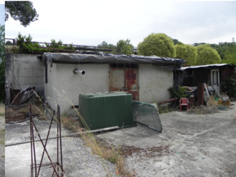
deposito con pollaio
