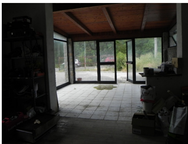
portico con tettoia in legno
