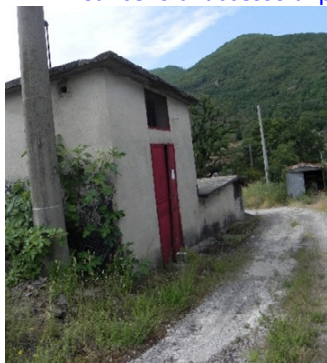
Deposito ex cabina Enel
