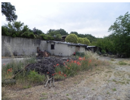
piazzale sovrastante il muro in cls
