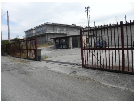
Cancello di accesso al piazzale del fondo a valle
