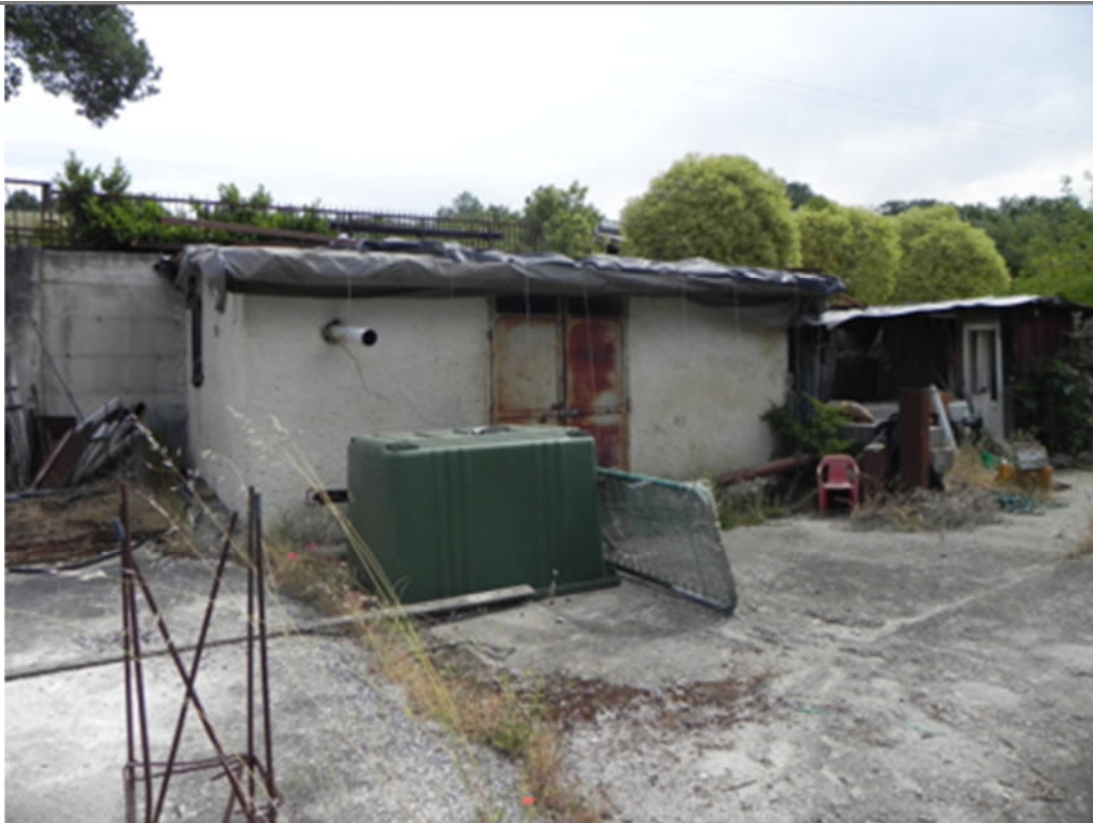
deposito con pollaio
